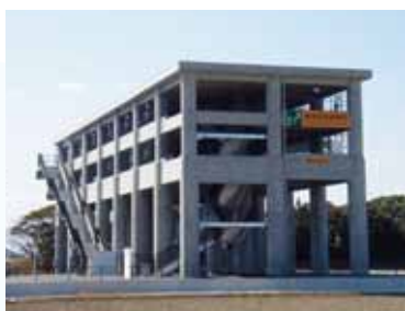
津波避難施設(タワー)
