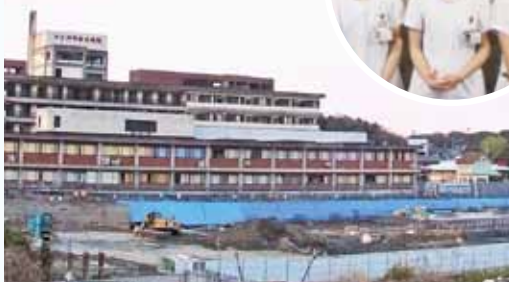
建設が進む伊勢総合病院（平成29年4月2日現在）
